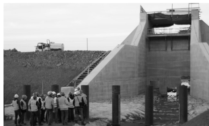
Die Chemnitzer Ingenieure besichtigen das 12,5 m hohe Auslaufbauwerk des Hochwasserrückhaltebeckens Neuwürschnitz.
