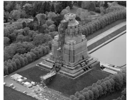
Wahrlich eine monumentale Aufgabe: Die grundlegende Sanierung des Völkerschlachtdenkmals
