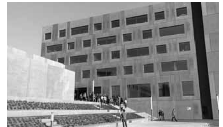
Ingenieure und Architekten besichtigen die Fassade des sanierten Adolf-Ferdinand-Weinhold-Baus an der Technischen Universität Chemnitz.
