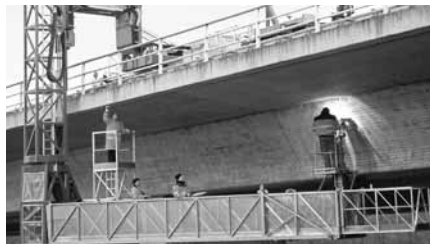
Mit den neuen VFIB-Empfehlungen erhalten Bauwerksprüfer, aber auch Auftraggeber eine solide Grundlage zur Leistungsbeschreibung und Aufwandsermittlung.
